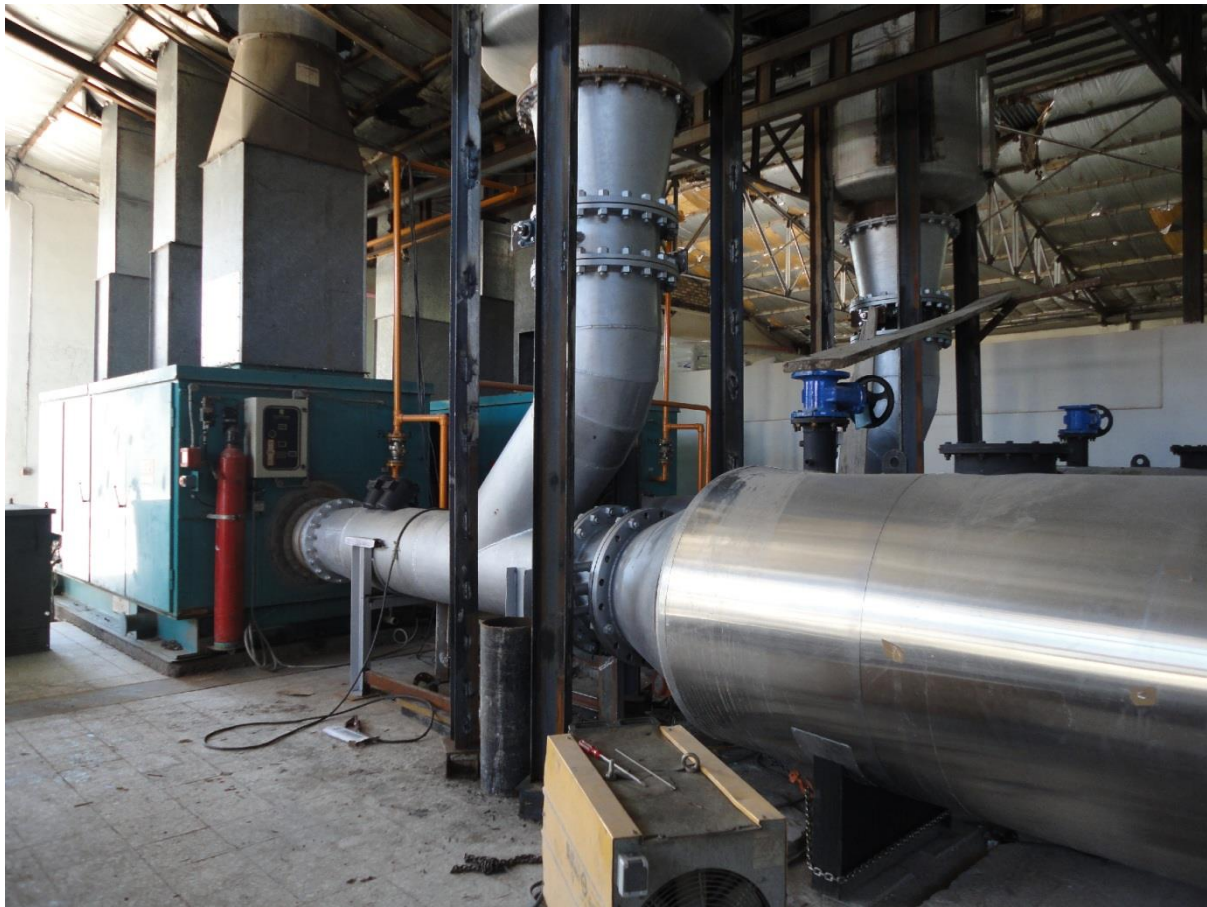
یک نمونه واحد تولید همزمان توربین گاز در ایران (اجرا شده توسط شرکت وستوی)
